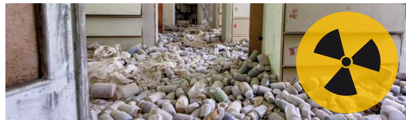
Mesto duchov sa stalo obľúbenou turistickou atrakciou. Väčšou hrozbou než rádioaktivita sú už ale v dnešnej dobe skôr polorozpadnuté budovy, do ktorých je od roku 2012 zakázaný prístup. Reaktor elektrárne, v ktorom nastal výbuch, už odpočívajú pod bezpečnostným sarkofágom.
